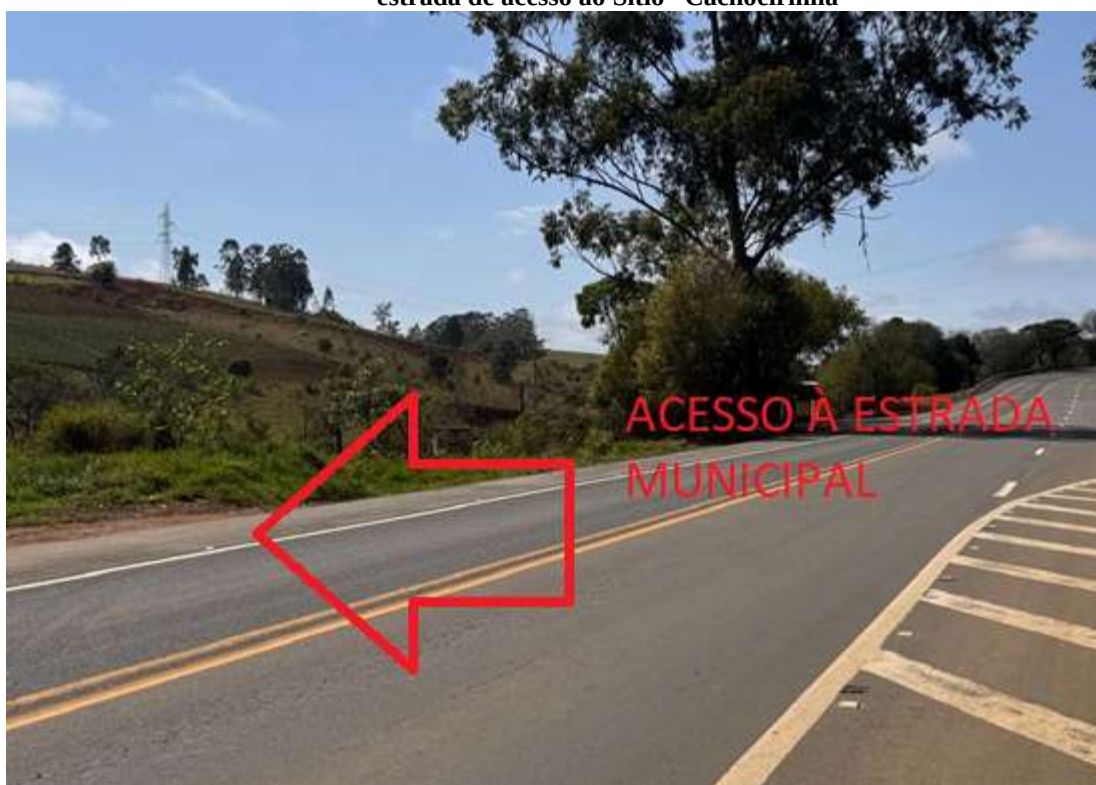
Figura 4- vista do acesso Rodovia à Estrada Municipal que liga ao Sítio “Cachoeirinha”
