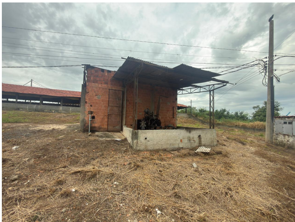
Casa de máquinas
